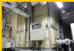
約8万ℓの水を供給可能な 自水槽タンク(末盛)
