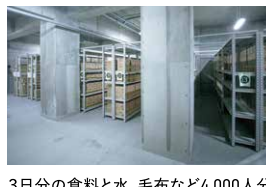
3日分の食料と水、毛布など4,000人分を想定した備蓄品を保管する防災倉庫
