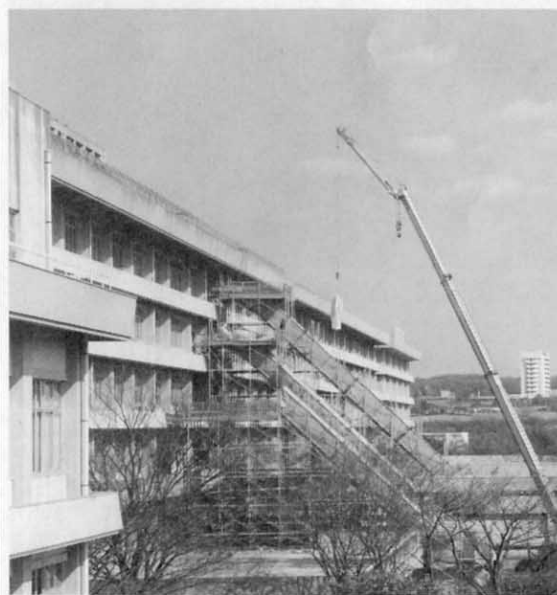
3号館の耐震工事
